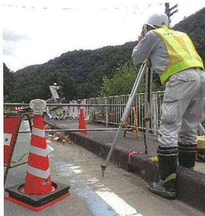
「西日本豪雨災害」での測量業務
